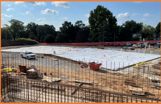
Area C - Slab-on-Grade Pour #2
