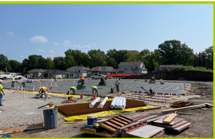
Classroom Wing - Slab-on-Grade Pour #1
