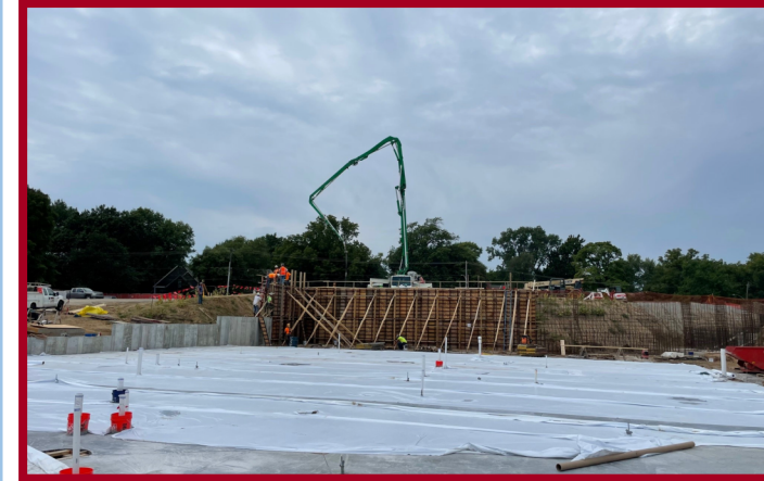
CIP Retaining Wall Pour #1
