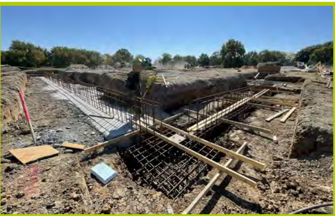
Area A Footing Pours & Stem Wall Rebar
