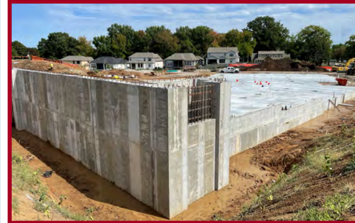
Retaining Wall Pour #1 - Formwork Striped
