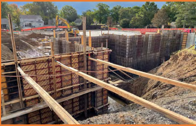
Retaining Wall Pour #2 - Rebar & Formwork
