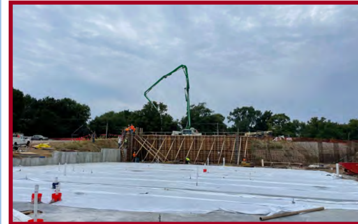
CIP Retaining Wall Pour #1
