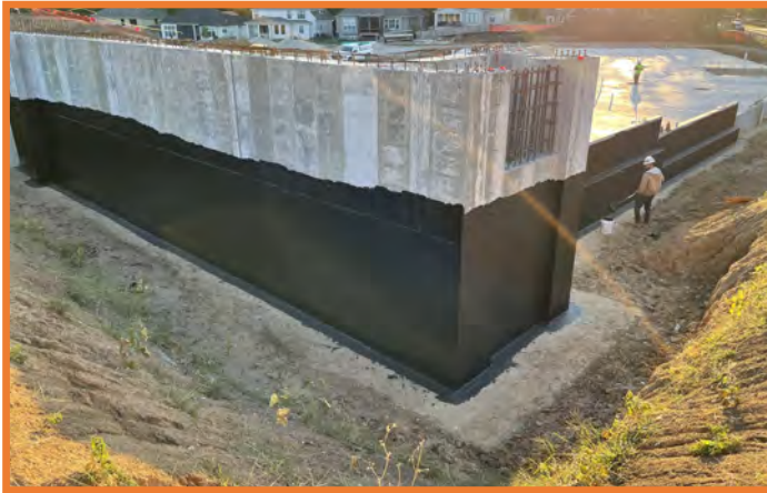
Wall Pour #1 - Waterproofing
