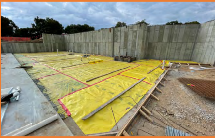
Area C - Slab-on-Grade #3 Prep & Pour
