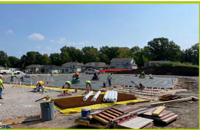
Classroom Wing - Slab-on-Grade Pour #1
