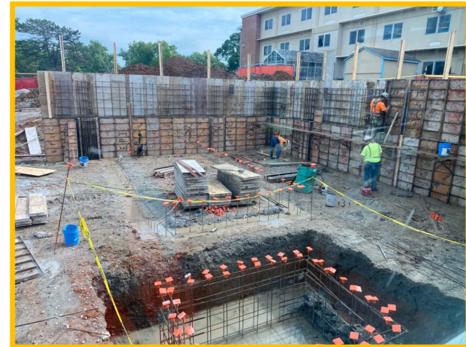
Form & Pour CIP Foundation Wall
