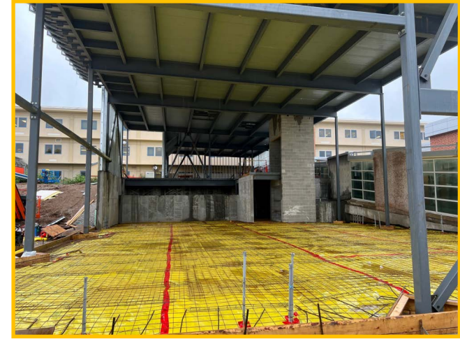
Lower Level Slab on Grade Pour
