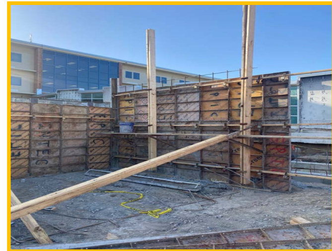
Form & Pour CIP Foundation Wall
