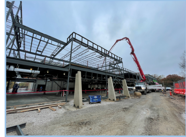
Area A Slab on Deck Pour
