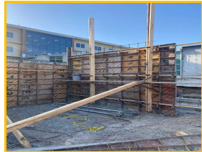
Form & Pour CIP Foundation Wall
